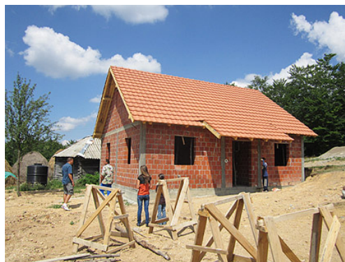
Die Hauserrichtung läuft auf Hochtouren
